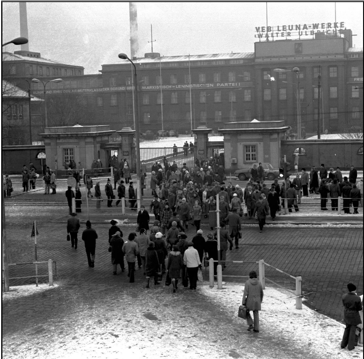
Abbildung 9: LASA, I 525, FS Nr. 115533 VEB Leuna-Werke, Schichtwechsel am Tor der Jugend, im Hintergrund Hauptverwaltungsgebäude Bau 24 (28. Jan. 1976)
