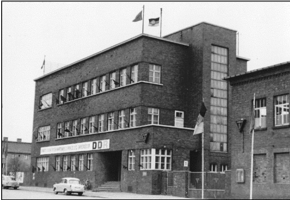
Abbildung 15: Junkalor Verwaltungsgebäude Dessau, 1926; LASA
