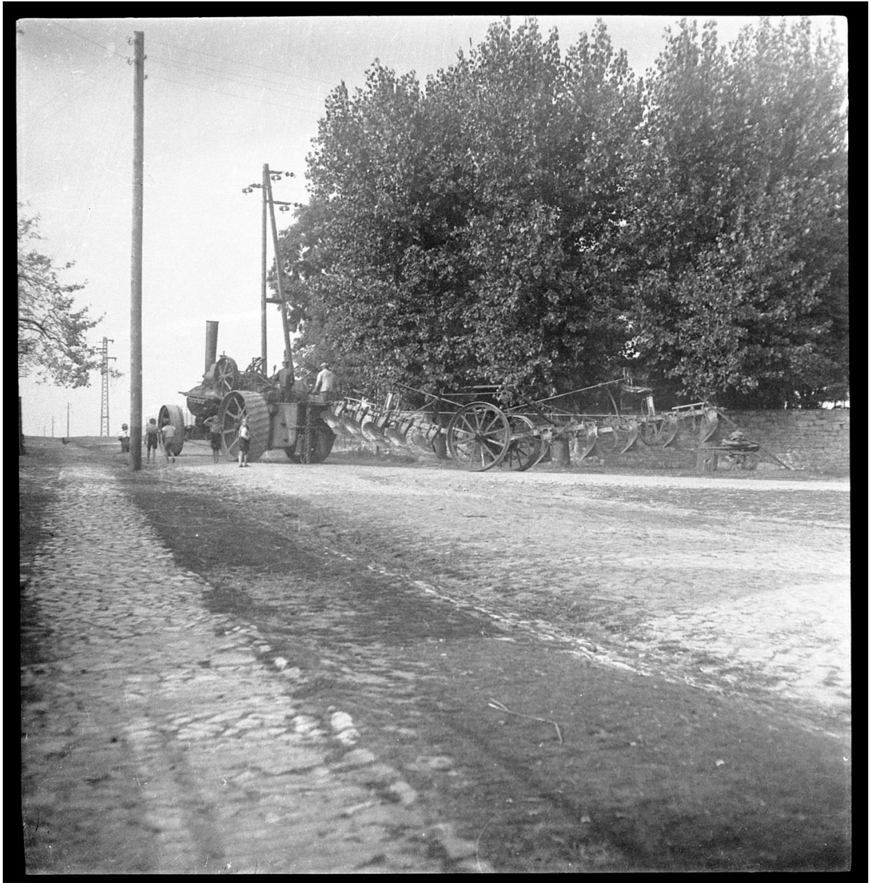
Abbildung 30: Dampfpfluglokomobile und Kippflug auf der Fahrt zum nächsten Ackerpflügen, um 1960. Foto: Fritz Giesecke; Eigentümer des Negativs: Börde-Museum Burg Ummendorf
