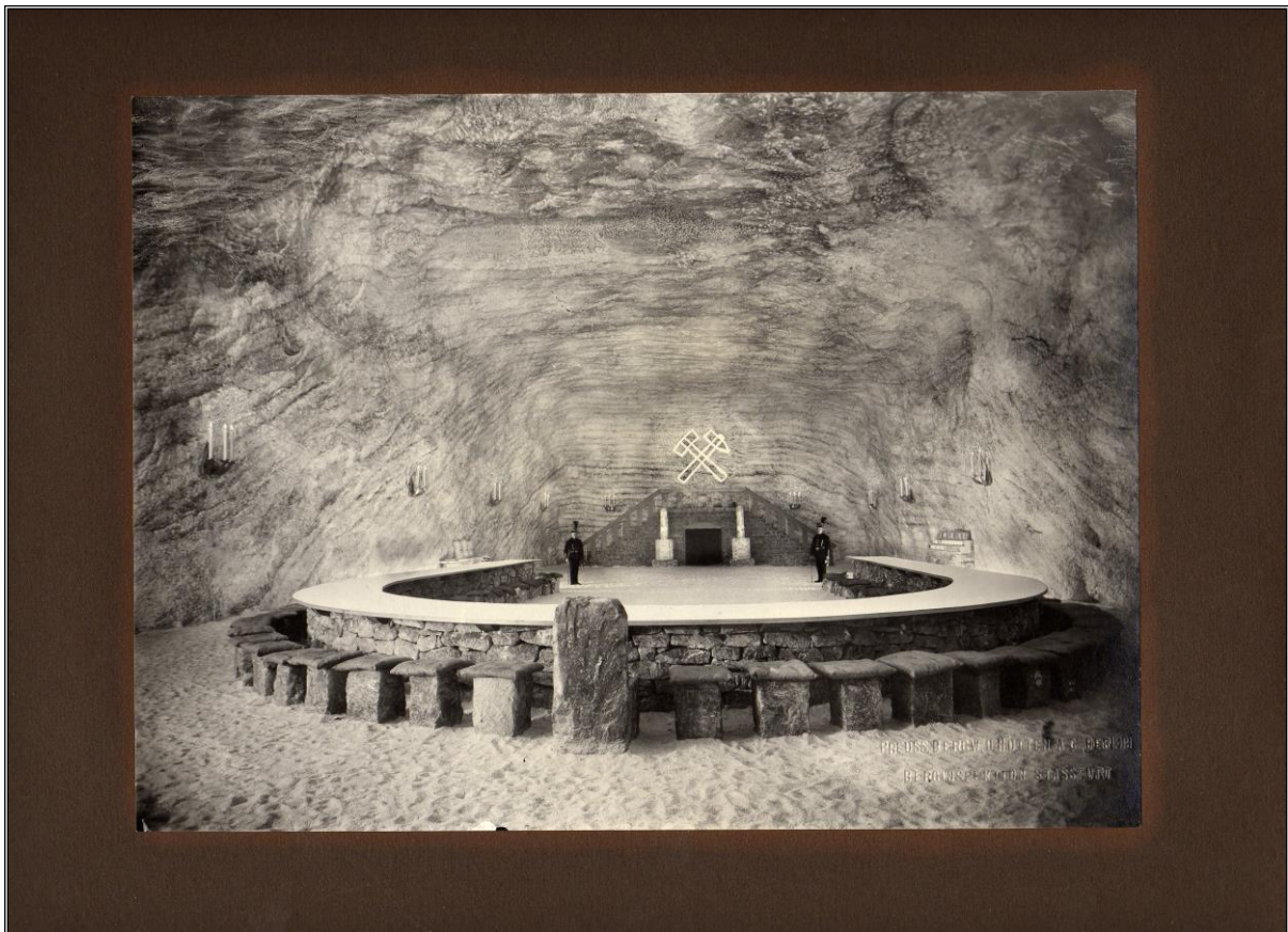
Abbildung 18: Schachtanlage Berlepsch-Maybach, Festsaal auf der 406 m Sohle; Inhaber Stadtarchiv Staßfurt; mit freundlicher Genehmigung des Museumsverbandes Sachsen-Anhalt e.V.
