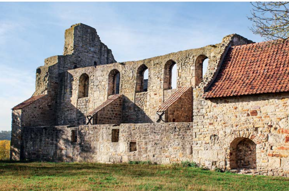
Blick auf die 25 Meter über dem Allertal gelegene Ruine der ottonischen Stiftskirche Walbeck an der „Straße der Romanik“.
