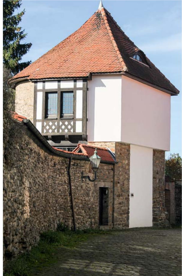
Sanierter ehemaliger Wachturm (Goldackerturm) an der alten Stadtmauer
