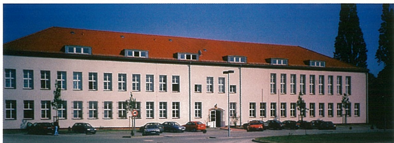
Das Haus 18 in der Merseburger Straße in Halle
