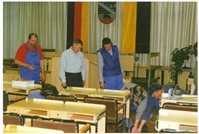
Demontage der Sitzreihen im Plenarsaal
