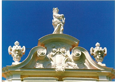
Giebelgestaltung im Bereich des Haupteinganges Domplatz Nr. 8
