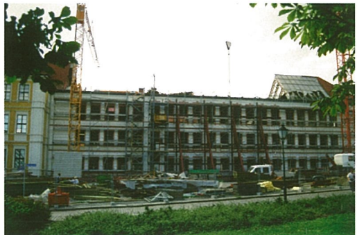
Umbauarbeiten am Gebäudeteil Domplatz Nr. 6
