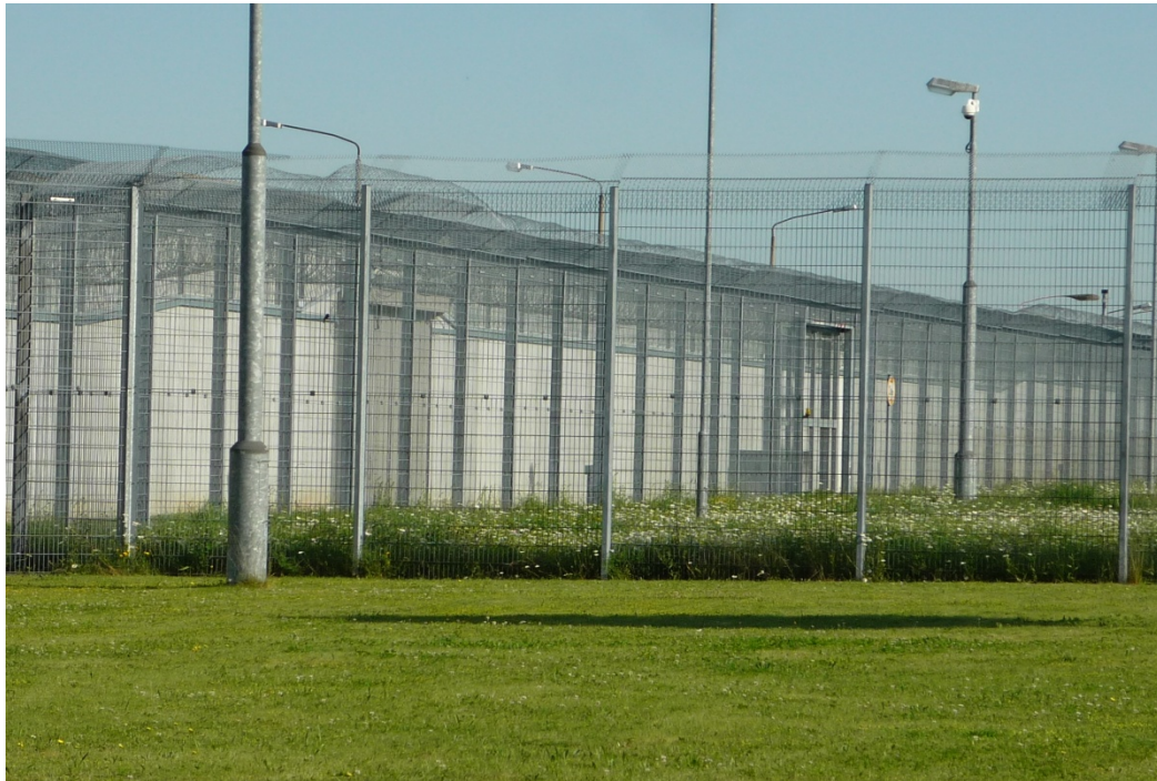
Abb. 2 Außenumweh rung der JA Raßnitz in Richtung Notzufahrt
