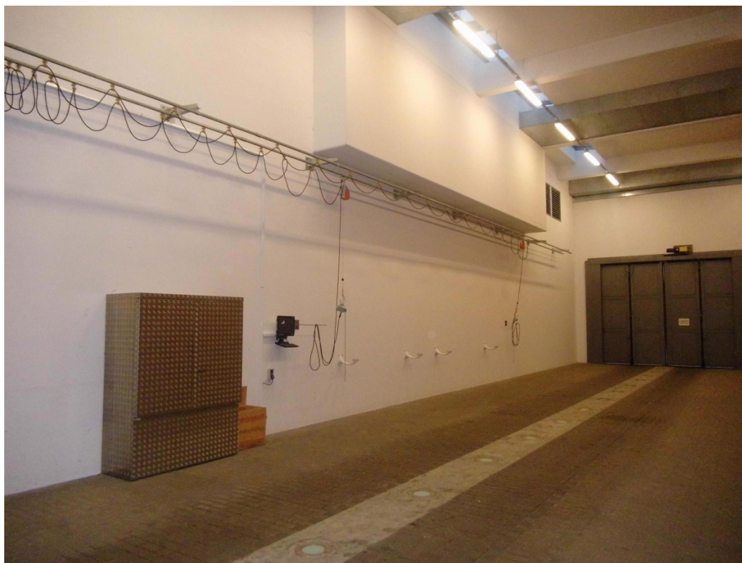
Abb. 13 Kfz- Schleuse mit Detektionsgerät
